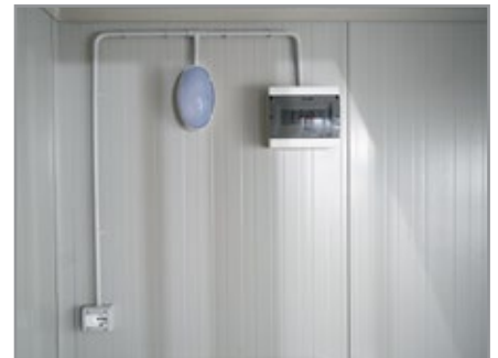
Elektropaket (10 W LED-Lampe mit Schalter, 16 A Schukostecker, Sicherungsbox, Außenanschluss und Erdkabel)
