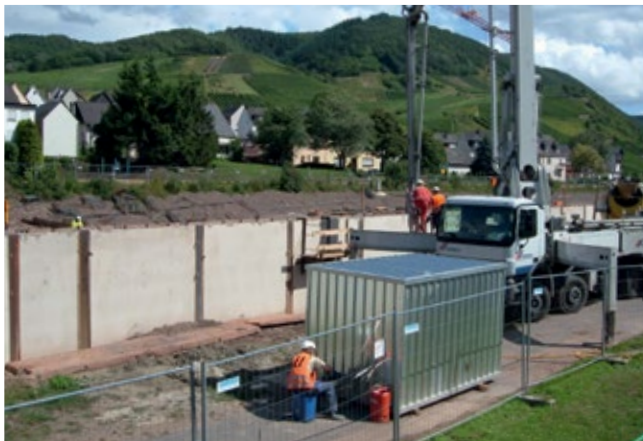
SC3000 auf einer Baustelle an der Mosel
