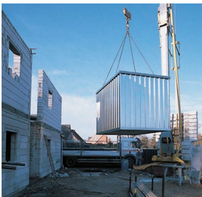
Mit 4 serienmäßigen Kranösen bis 3 Tonnen kranbar
