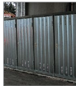
Container mit Kiemen zur Belüftung
